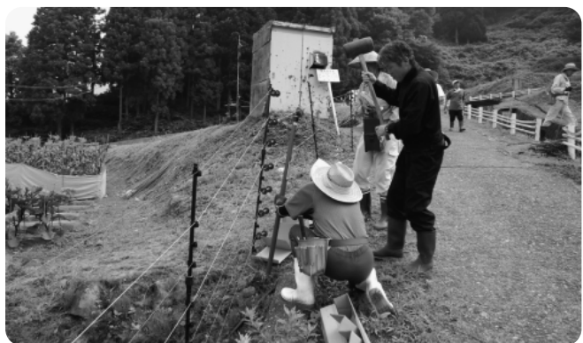
▲起伏が激しい箇所も杭の間隔を微調整し設置していく。
