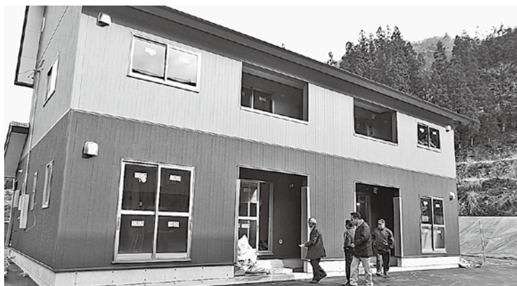
建設中の中土戸石公営住宅（2棟4戸）
