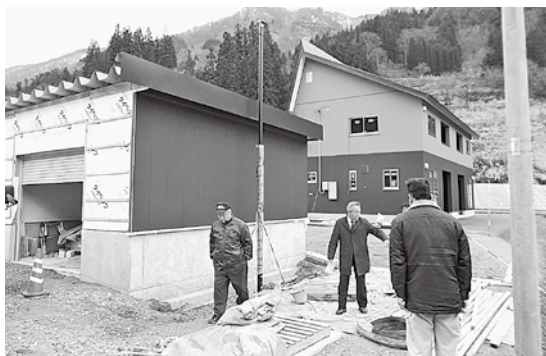
建設が進む公営住宅
