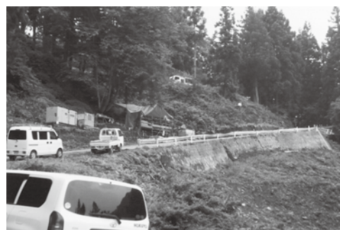
着工した梨平線の工事
