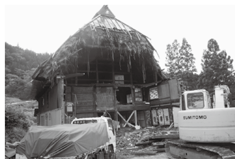
被災家屋の解体作業
