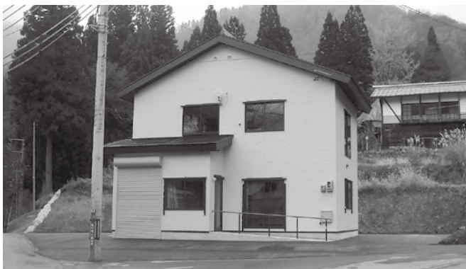
深原避難所新築
