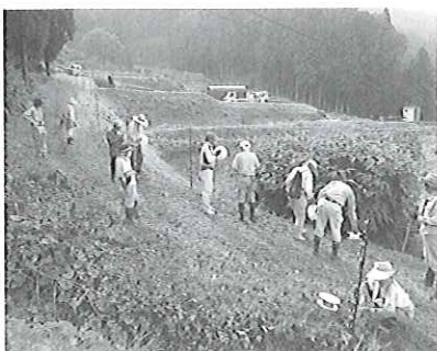
電気柵設置作業
