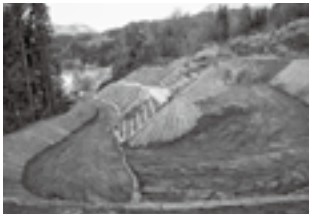
宮本伊折間を県代行で施工中
