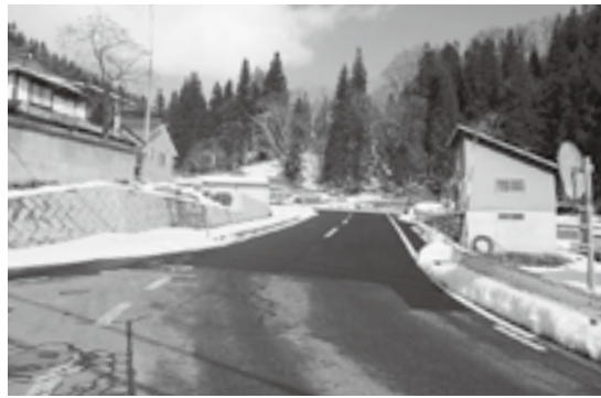
中島地籍道路工事後
