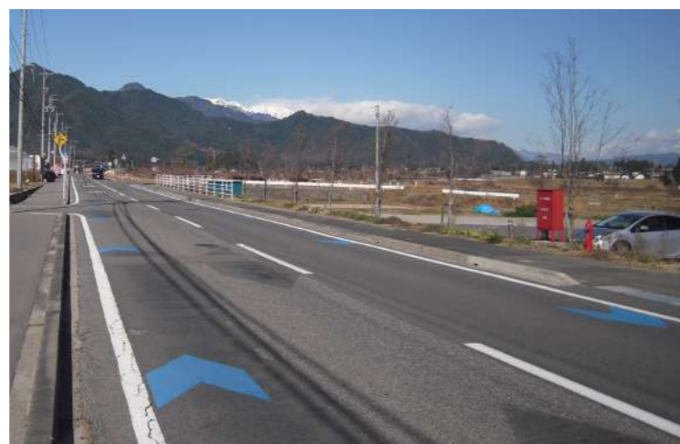
県道有明大町線 松川村安曇野ちひろ美術館付近に 設置されている矢羽根型路面表示
