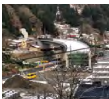
工事が進む雨中月岡バイパス
