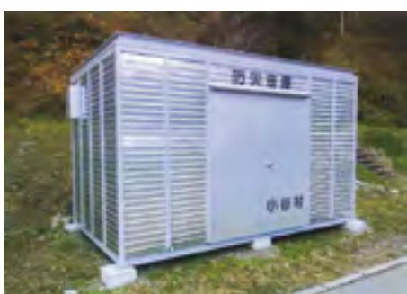
小谷小学校へ設置されているコンテナ型備蓄倉庫
