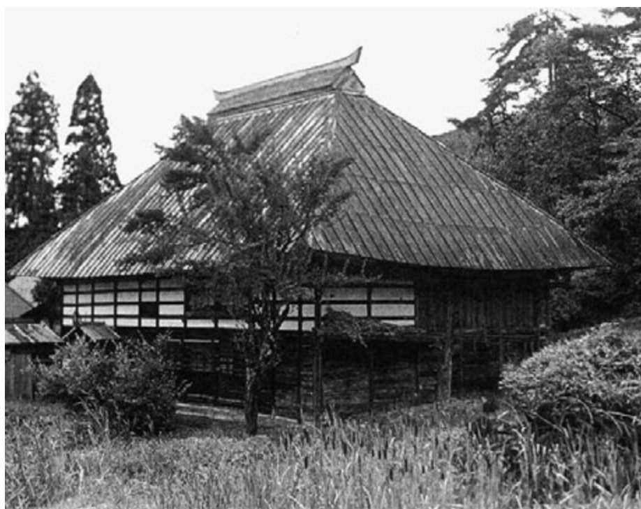
再利用された古民家
