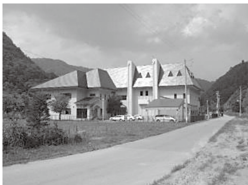
23年経過したクリーンコスモ姫川
