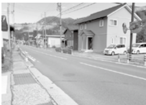
標示が消えた横断歩道
