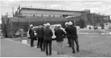
福島町「新潮学舎」建設中
