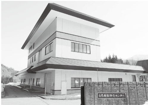
「白馬乗鞍浄化センター」長寿命化
