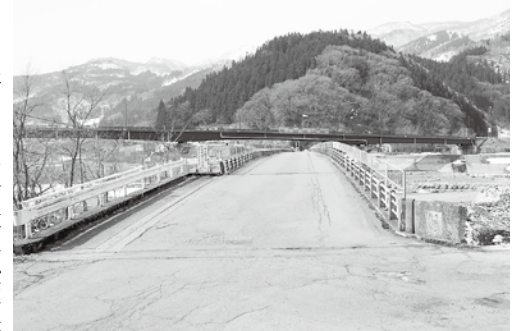
「小谷橋」橋梁長寿命化
