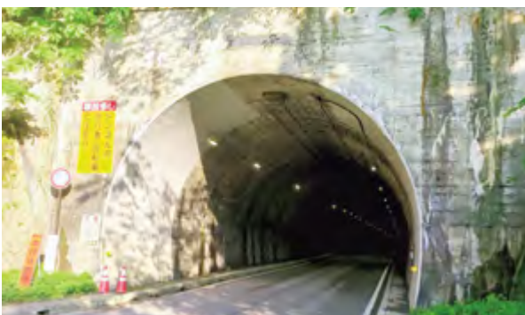
緊急性のある外沢トンネル（L=1360m 昭和49年完成）
