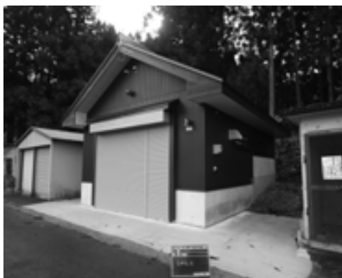
令和2年12月竣工 大網消防小屋
