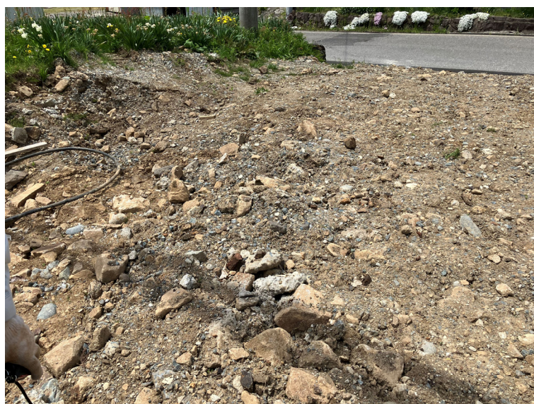
写真 1-2 県道側は礫質土（搬入土）が敷設されている
